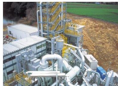
キルン式ガス化システムの実証プラント (処理規模: 20t/日 〓 びたちなか市)
